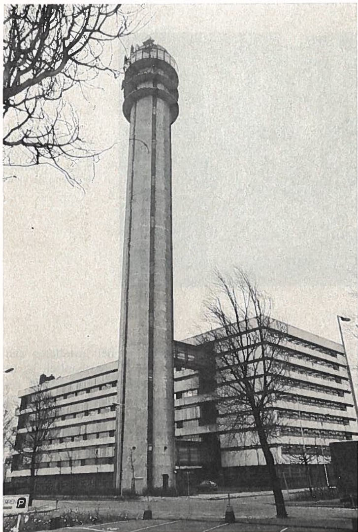
De telefoon- en telexcentrale met straaltoren Rotterdam-Charlois waar NSEM Metaconta 10-C apparatuur installeert.
